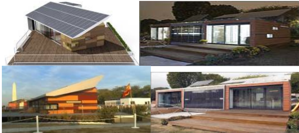
Figura 15: Imágenes de casas fotovoltaicas
